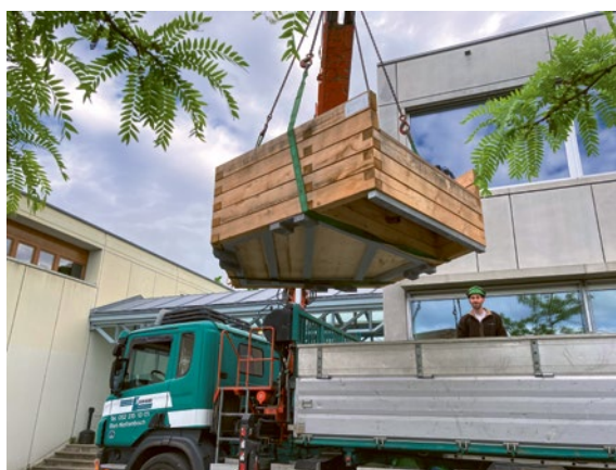
Pflanztröge werden angeliefert.
